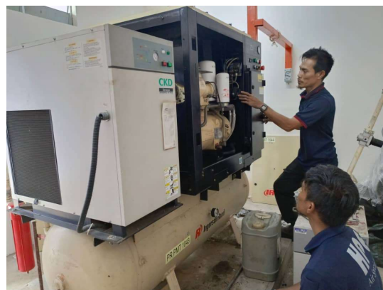
Kerja pembaikan 1 unit pemampat udara makmal FKTM A17 pada 24 Feb 2025
